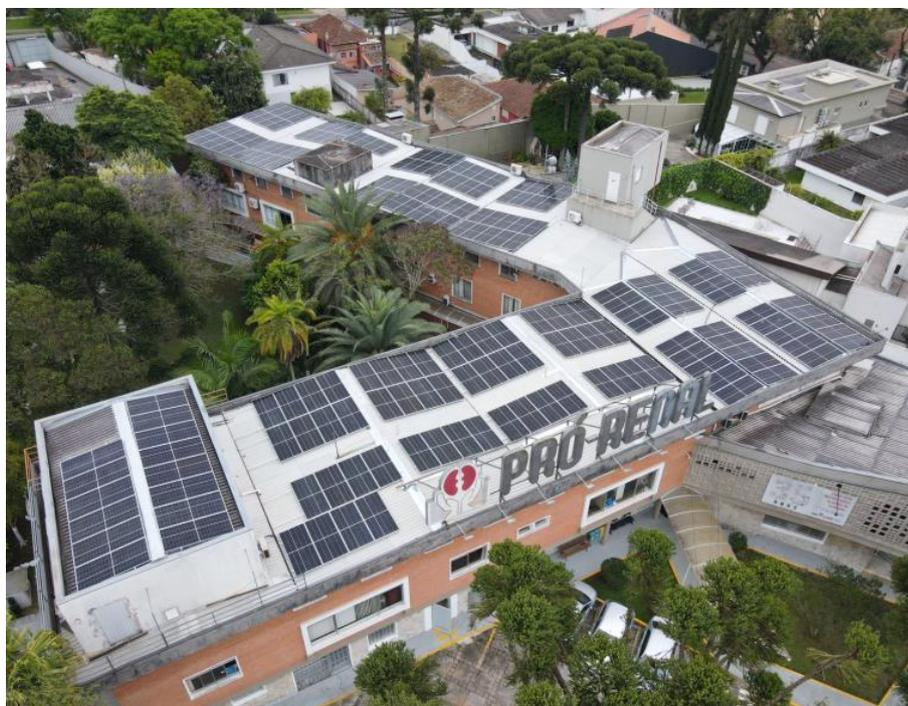
Imagem 2 – painéis foto voltaicos instalados
