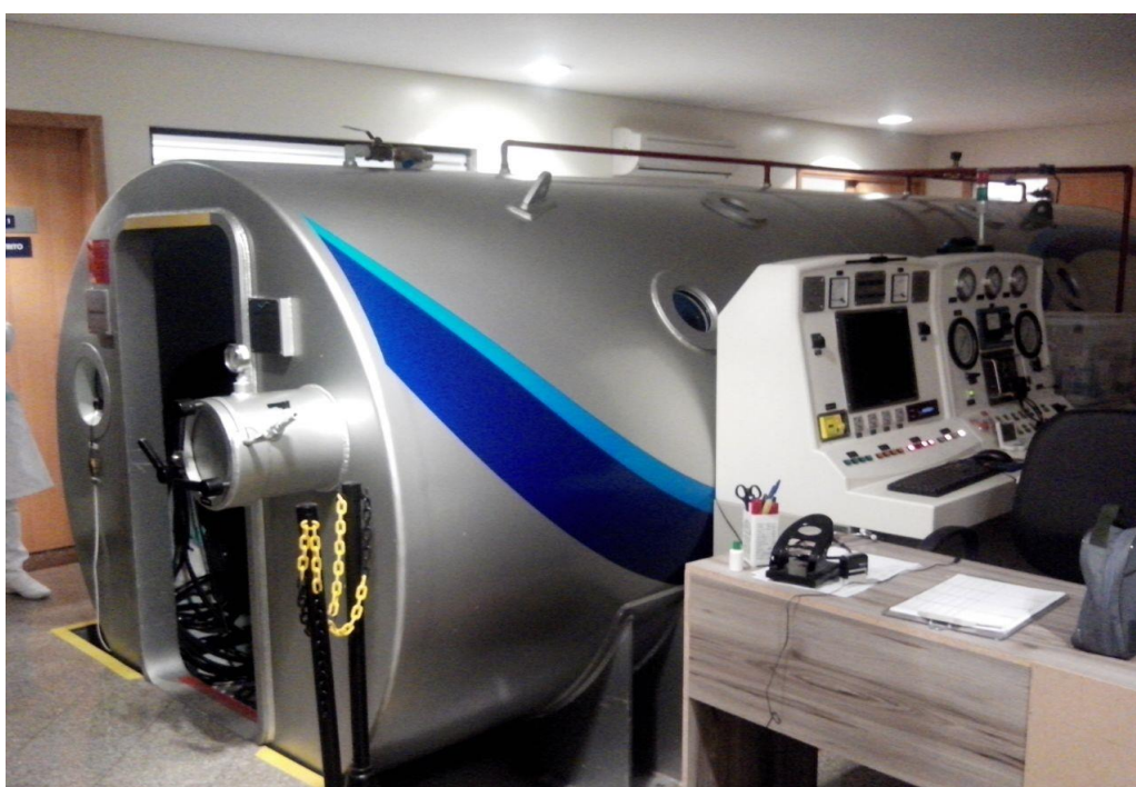
Figura 2 - Visita ao Hospital Pilar - Câmara Hiperbárica
